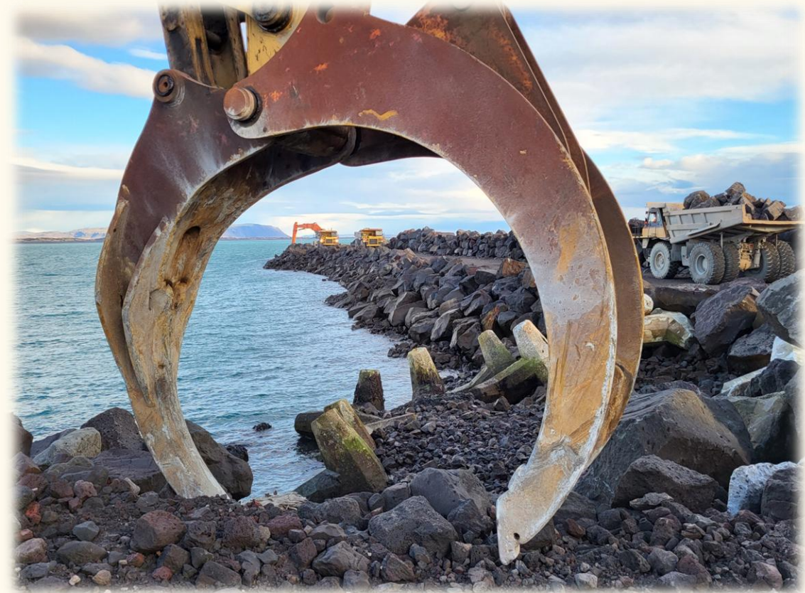
Framkvæmdir við stækkun Þorlákshafnar
