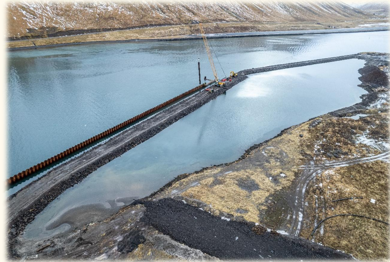
Framkvæmdir á Ísafirði 2022.
